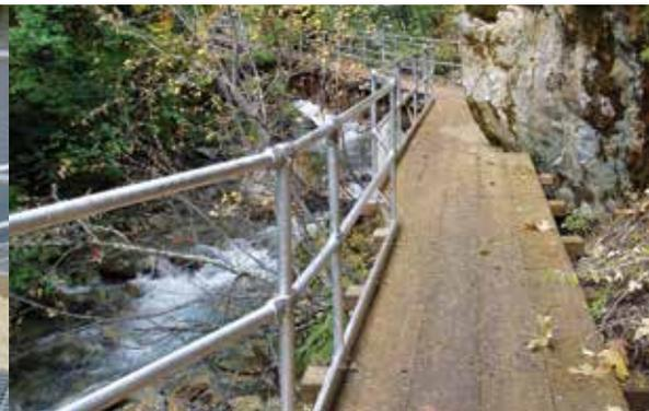
**KEE ACCESS** Rohrverbinder wurden zur Realisierung barrierefreier Treppen-, Rampen- und Wegegeländer im Sinne des §4 Behindertengleichstellungsgesetz (BGG) und zur Erfüllung der Anforderungen der DIN 18024 entwickelt. **KEE ACCESS** Rohrverbinder ermöglichen eine kostengünstige Lösung für Geländerkonstruktionen sowohl bei Neubauten als auch bei Sanierungen.
